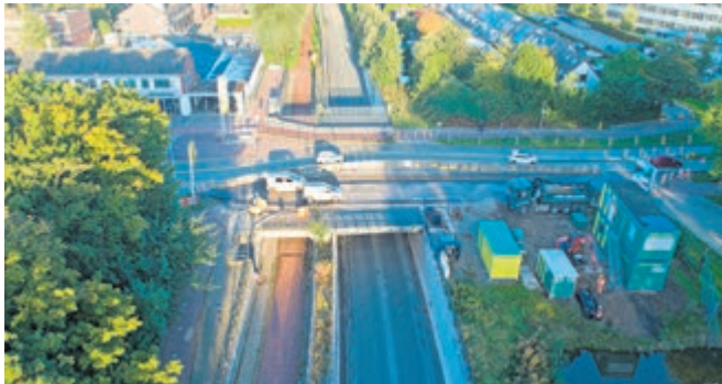
Op de Zijdelweg geldt een om-en-om-regeling, zodat verkeer doorgang vindt langs de werkzaamheden
