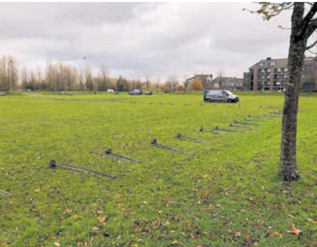
De ankers voor Luchthal De Scheg worden geplaatst op het evenemententerrein Legmeer-West>
