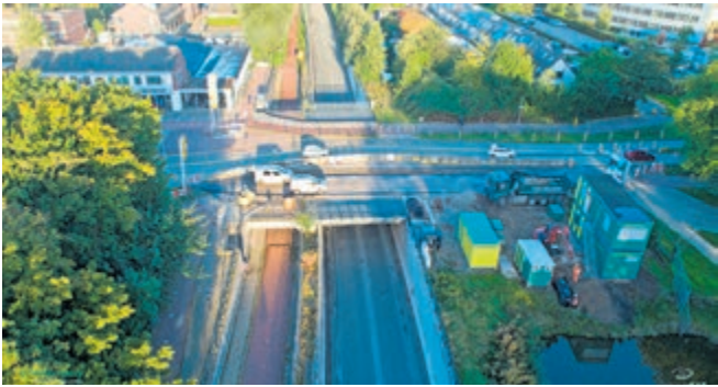
Op de Zijdelweg geldt een om-en-om-regeling, zodat verkeer doorgang vindt langs de werkzaamheden
