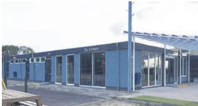
Nieuwe gevel Vinken kantine
