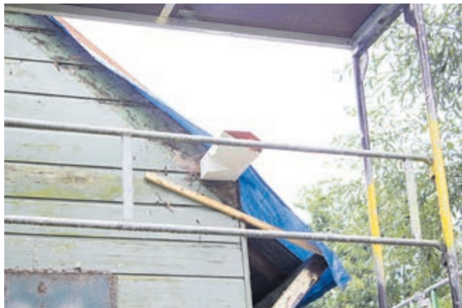
Het karakteristieke hout wordt volledig hersteld
