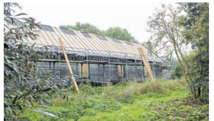
Het dak wordt geïsoleerd. Er zullen ook nog zonnepanelen worden geplaatst.
