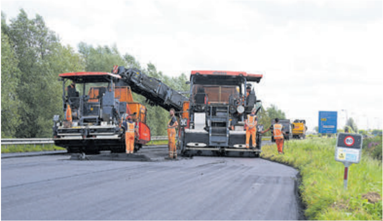
De werkzaamheden verlopen voorspoedig. Foto: Jan Uithol.
