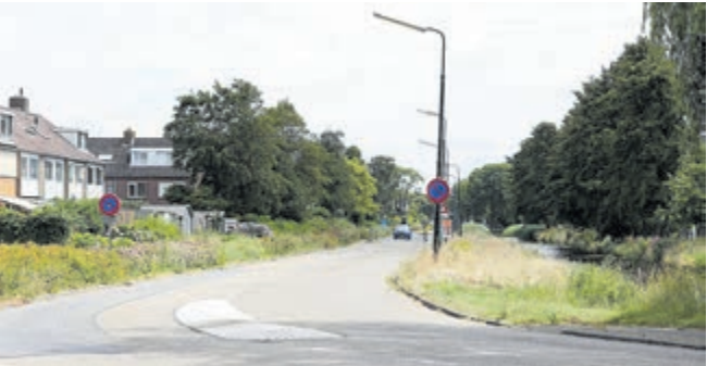
De Pastoor Kannelaan gaat vanaf 5 augustus compleet op de schop
