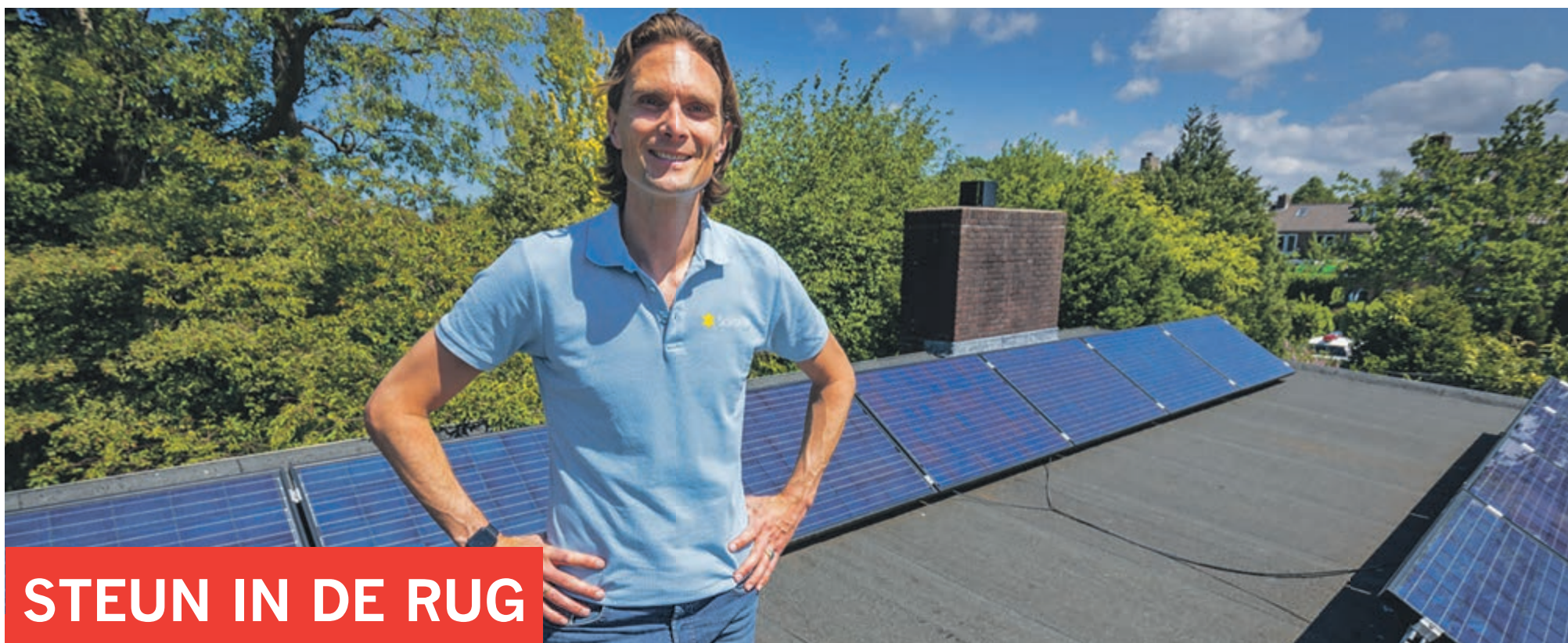
Roderick van Wisselingh op een dak met zonnepanelen
