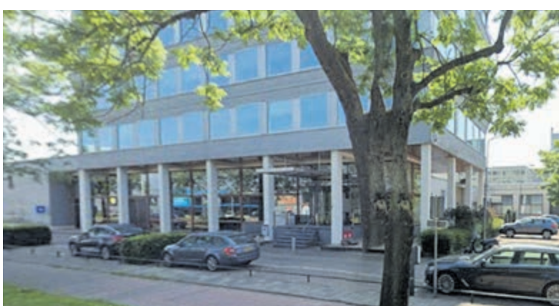
Het pand aan de Wiegerbruinlaan. Foto: aangeleverd.
