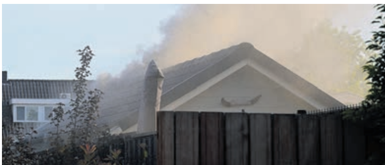
Rook- en waterschade na schuurbrand. Foto: aangeleverd.
