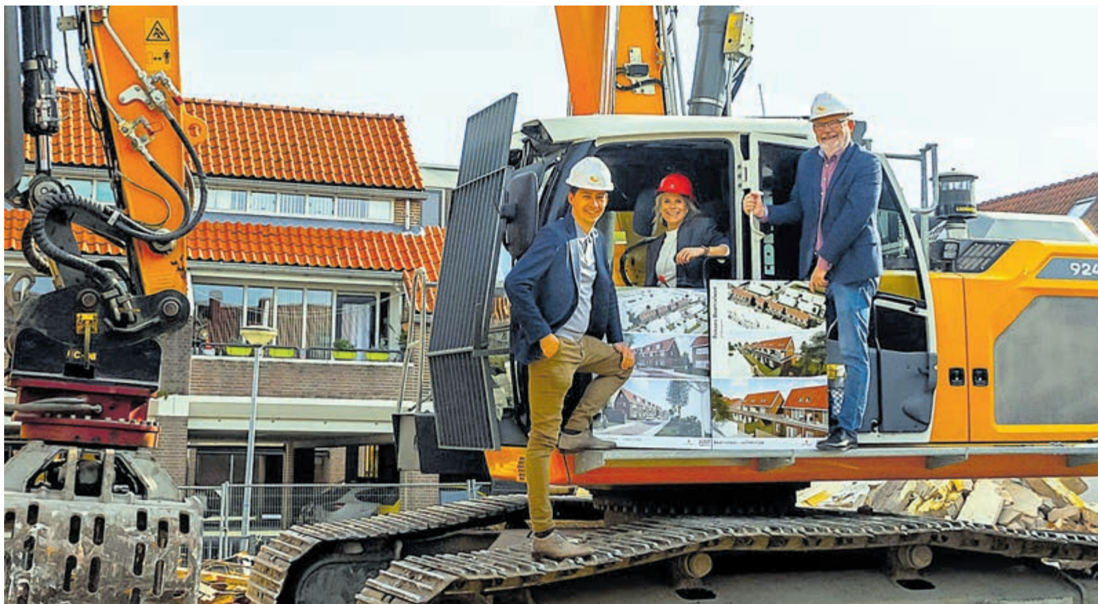
Nicole de Vrij en wethouders Hoekstra (links) en Hazen zijn klaar voor de start van de sloopwerkzaamheden aan de Prinses Beatrixlaan. Foto: Vincent Vink.
