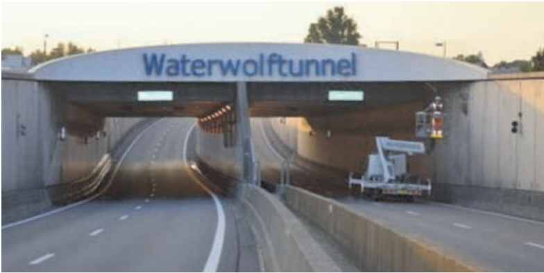
Werkzaamheden in de avonden en nachten van 6 tot 8 maart aan de Waterwolftunnel. Foto: archief.
