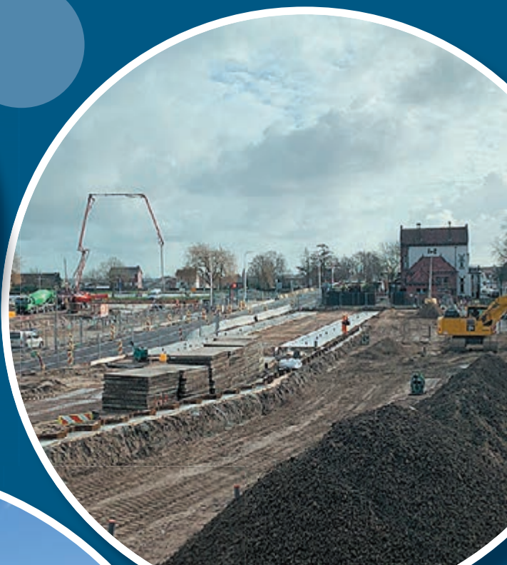
Start aanleg Uithoonlijn
