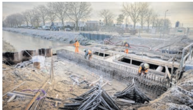
Nabij de Randweg komt een nieuwe brug over de Hoofdtocht
