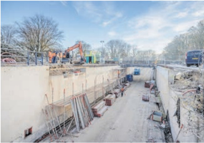
Het viaduct in de Zijdelweg krijgt een nieuw, dunner brugdek om ruimte te maken voor de tram
