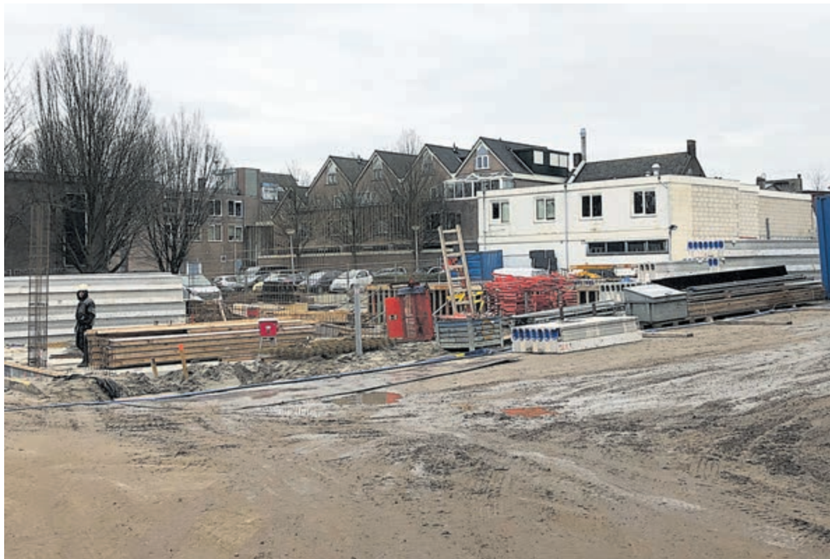
De bouwplaats De Reede in Uithoorn vanaf de achterzijde gefotografeerd
