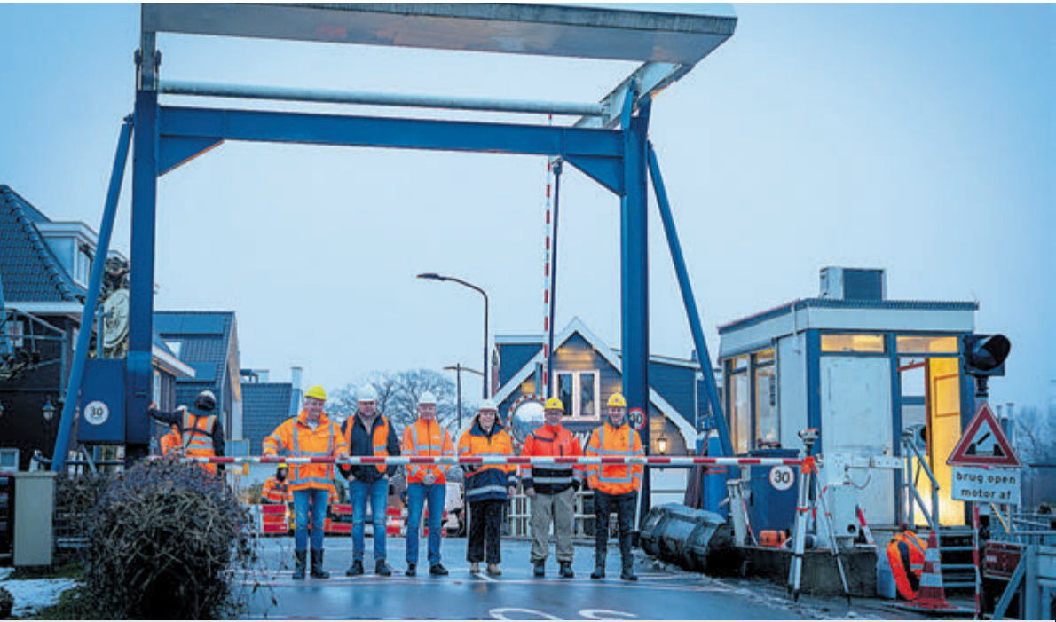
Wethouder Anja Vijselaar gaf samen met de projectorganisatie en de aannemers het officiële startsein voor de werkzaamheden. Foto: aangeleverd.
