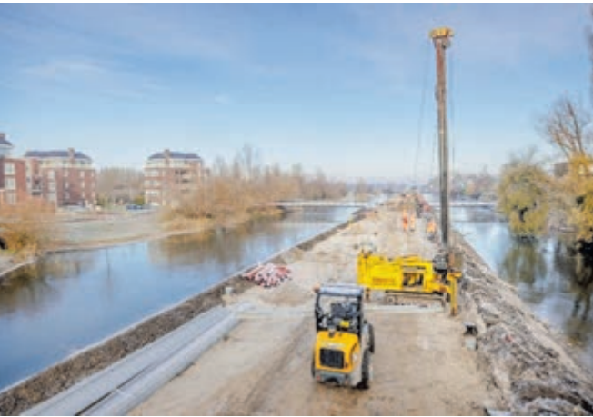
Op de spoordijk wordt komende maanden de trambaan aangelegd
