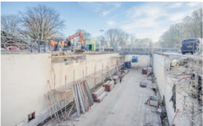
Het viaduct in de Zijdelweg krijgt een nieuw, dunner brugdek om ruimte te maken voor de tram
