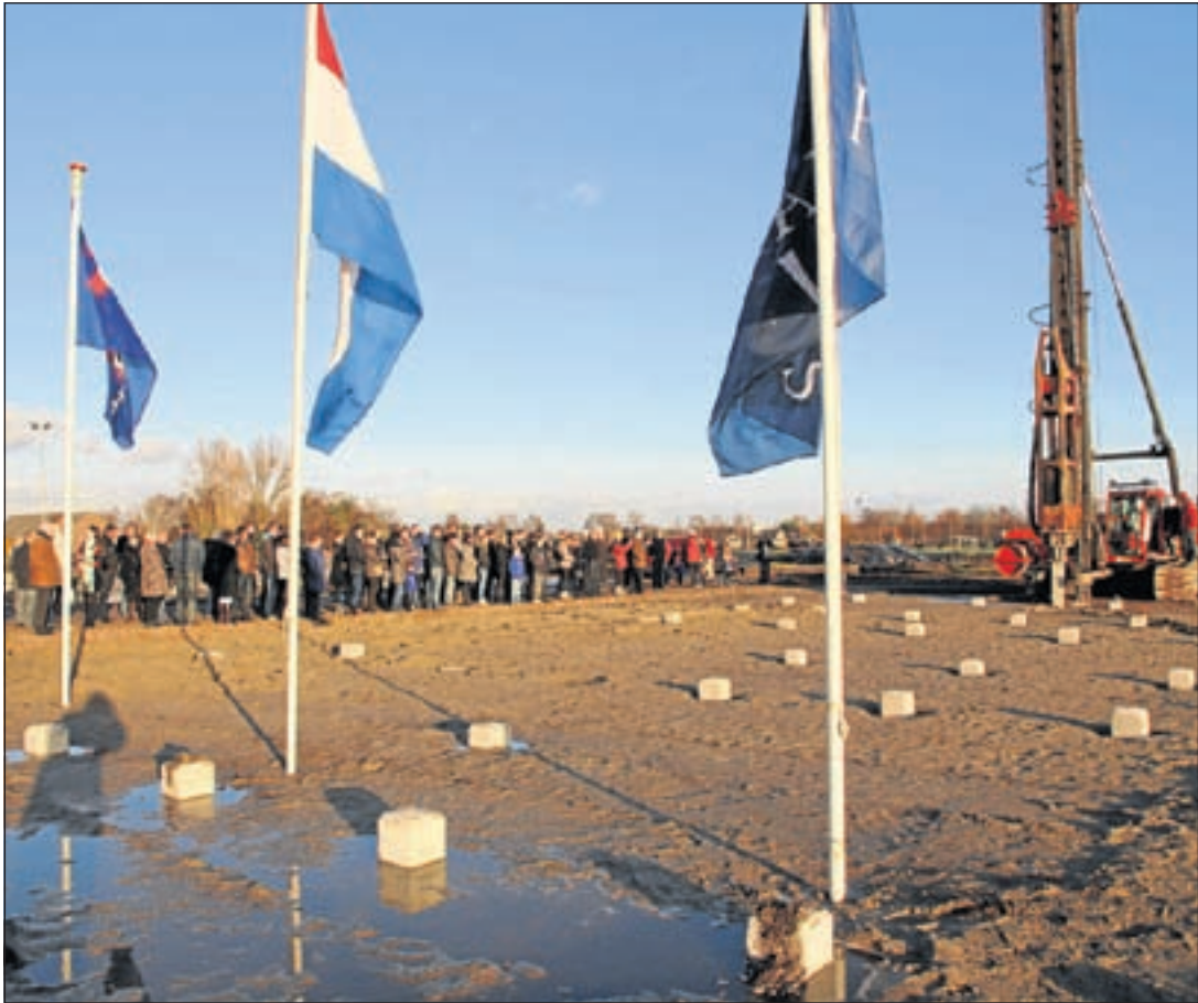
De laatste paal van het bouwproject De Oker wordt onder grote belangstelling door wethouder Jeroen Verheijen in de bodem geslagen
