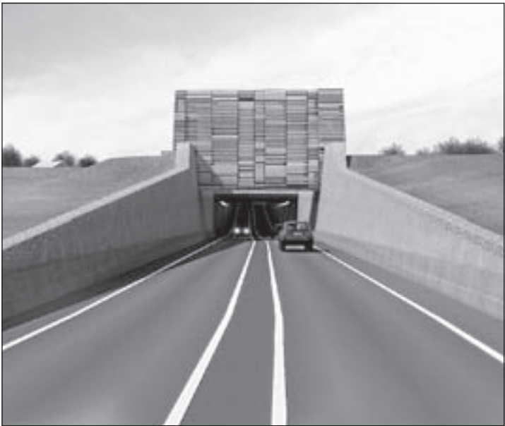
Noodkering in de toegang naar het aquaduct aan de kant van De Ronde Venen
