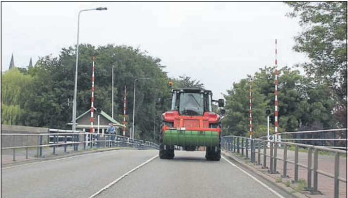
Over de Prinses Irenebrug is dit straks niet meer mogelijk
