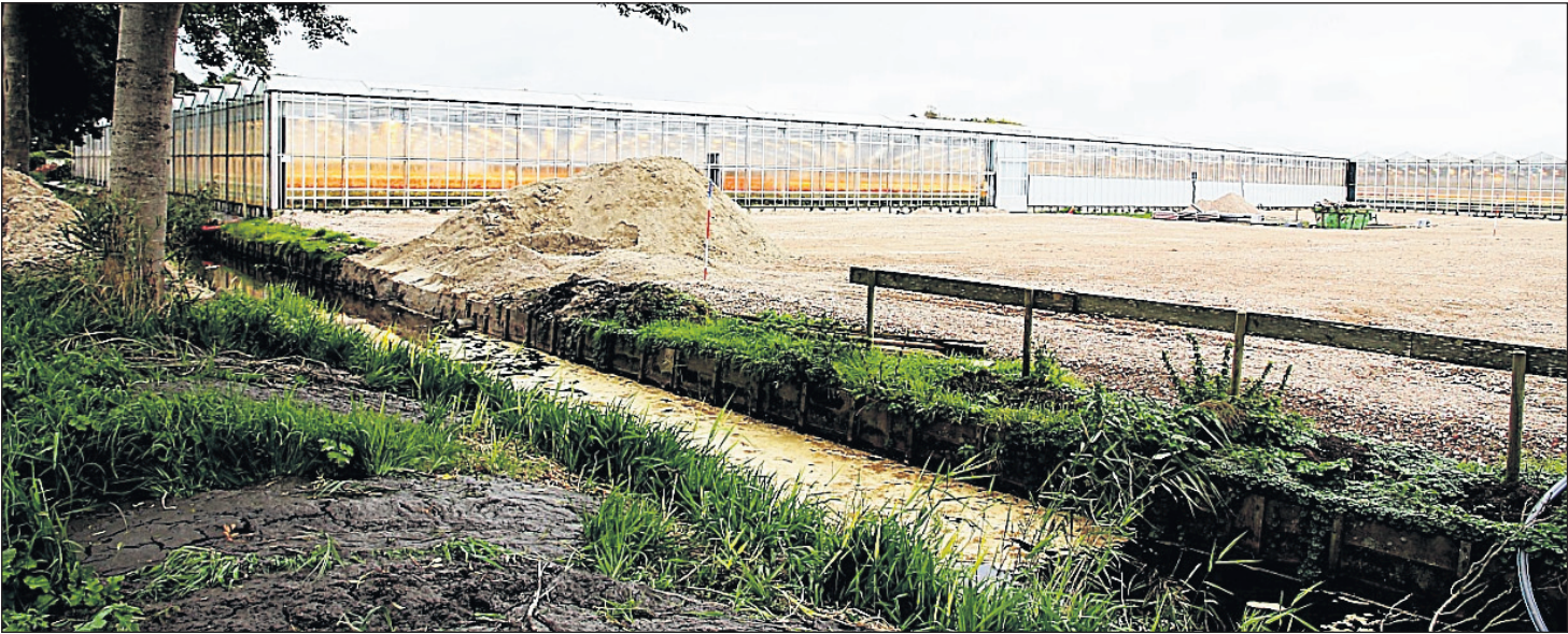
Achter de kassen is de locatie waar de installatie en de veldschuur worden geplaatst
