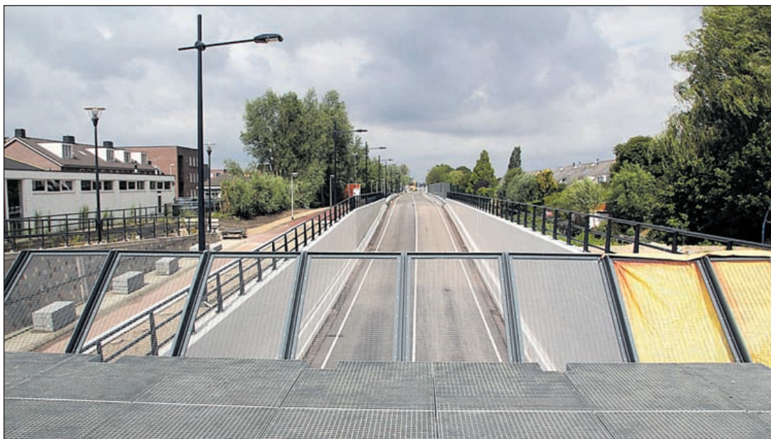
Busbaan en onderdoorgang aan de Zijdeweg worden aangepast t.b.v. de tram
