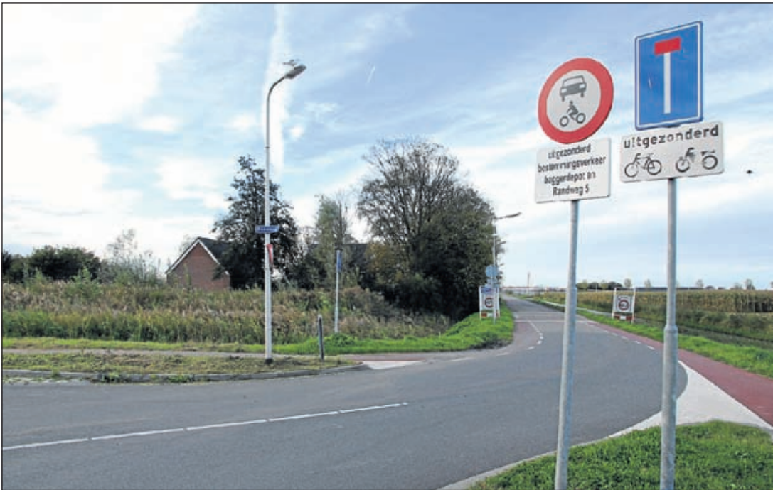
De verkeersborden hoek Randweg/Randhoornweg worden veelvuldig over het hoofd gezien
