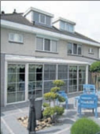
Kozijnen voorzien van geïntegreerde rolluiken op 1e & 2e etage
