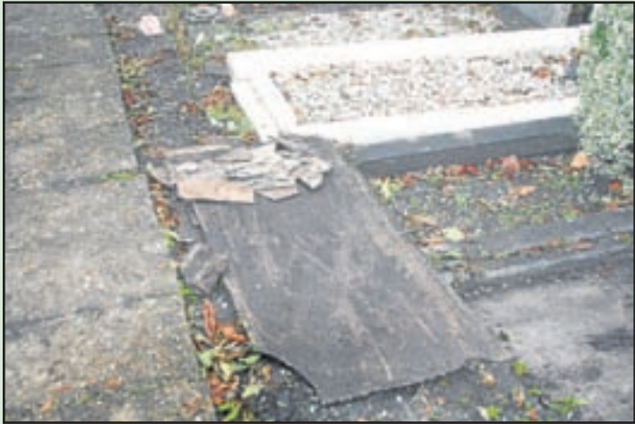
5: Bij de sloop van de grafmonumenten kwamen grote stukken asbest naar boven.
