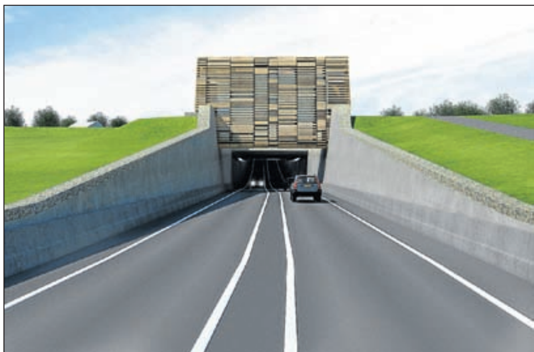
Het vervolg van de N201 en het aan te leggen aquaduct onder de Amstel blijven tweebaans
