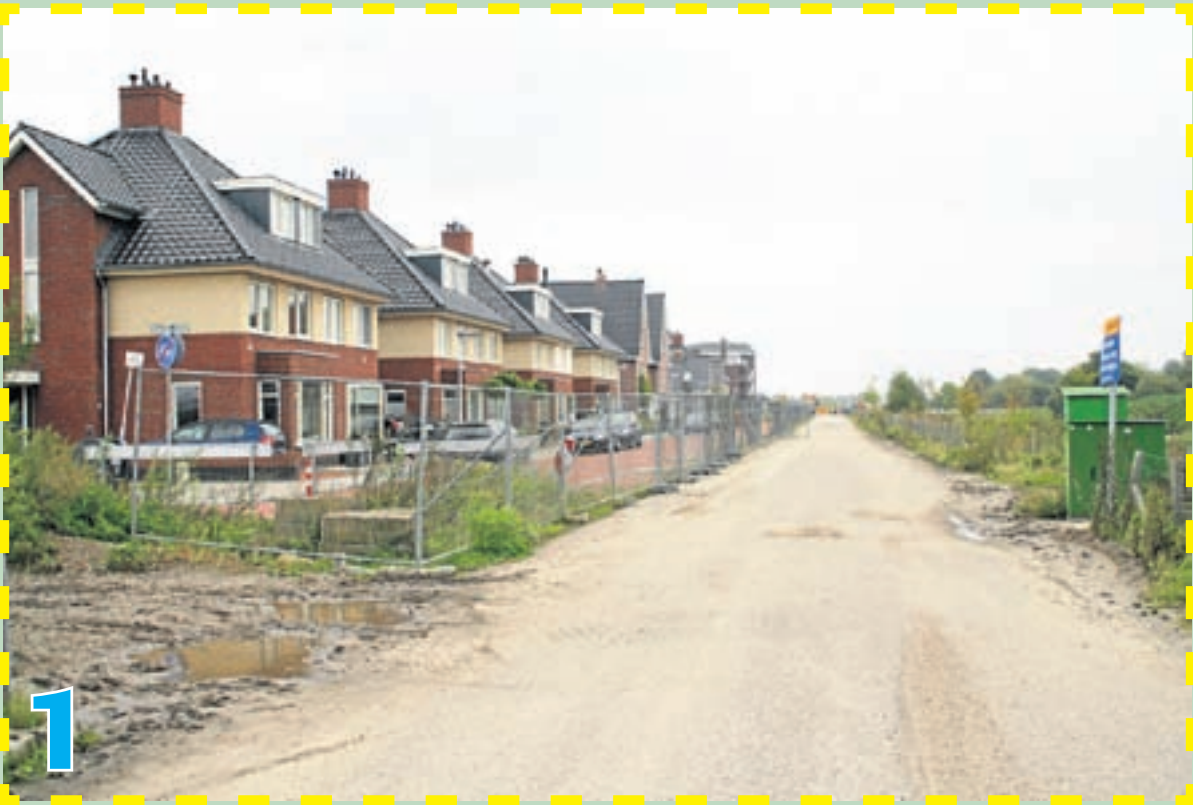
De bewoners van de Faunalaan krijgen in plaats van een bouwweg eindelijk een fatsoenlijke straat voor hun deur
