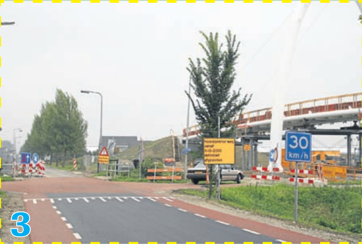
De Noorddammerweg wordt bij de kruising met de N201 afgesloten
