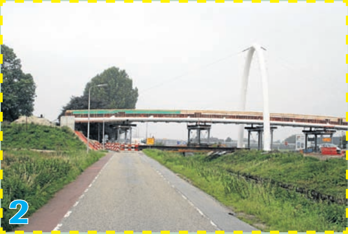
De Randweg wordt weer helemaal toegankelijk als de fietsbrug gereed is
