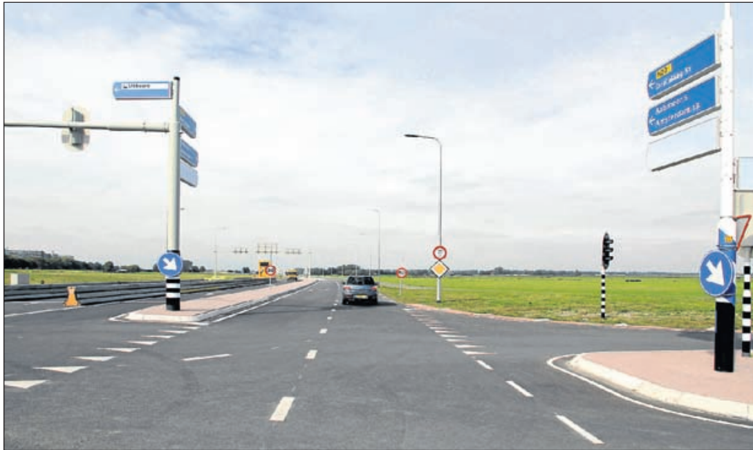
Kruispunt omgelegde N201 ter hoogte van de verlengde Amsterdamseweg. Vanaf hier tot aan de Legmeerdijk is een deel van de nieuwe weg beschikbaar voor het verkeer.
