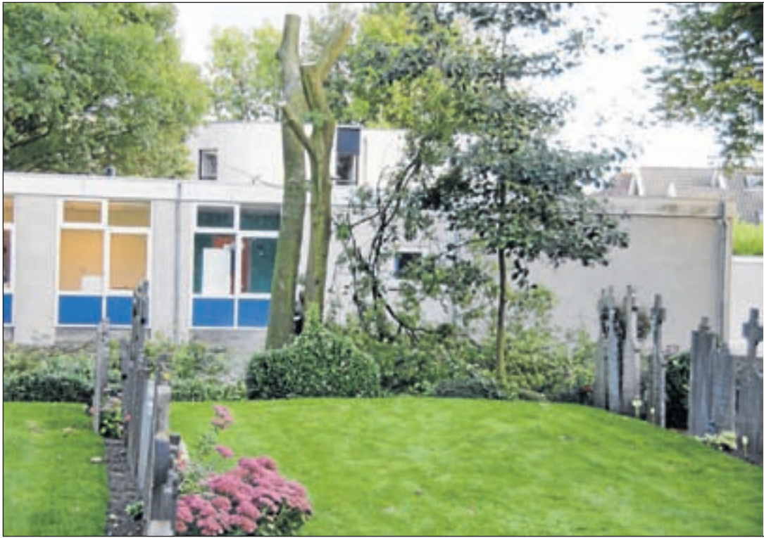
Het afgelopen weekend begon de ontmanteling met het kappen van een boom. Dat is nu weer (voor hoelang?) gestopt.
