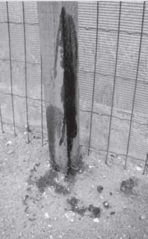
De omheiningspalen besprenkeld met gif
