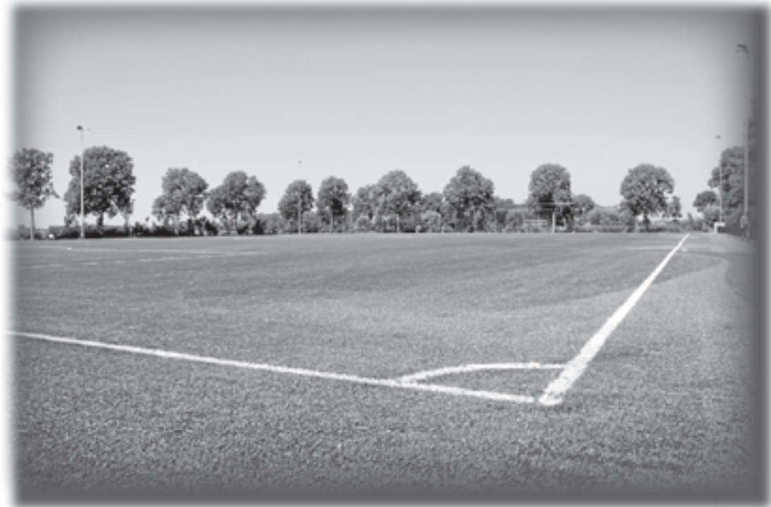
Het nieuwe kunstgrasveld in de laatste fase van de aanleg
