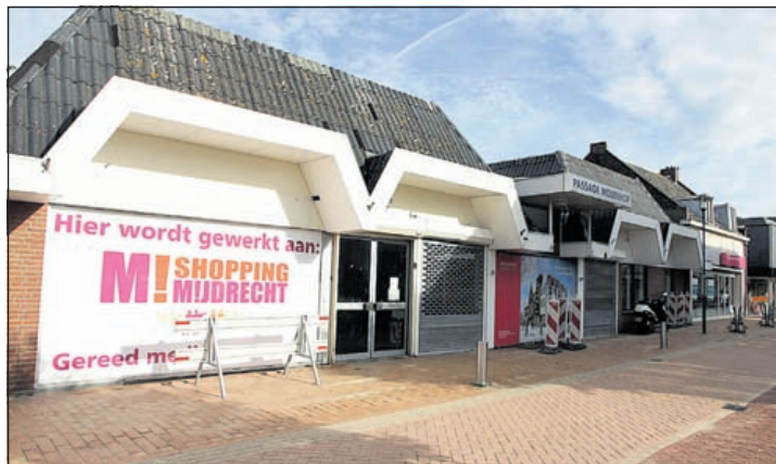
De oude opstallen rond Passage Molenhof worden in september gesloopt
