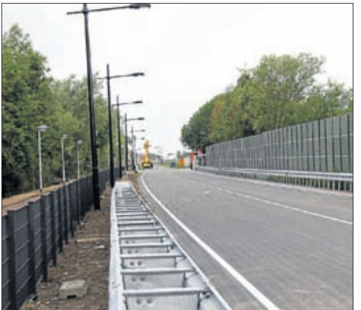
De afbouw van de busbaan in het stuk tussen de Weegbree en de Burgemeester Kootlaan
