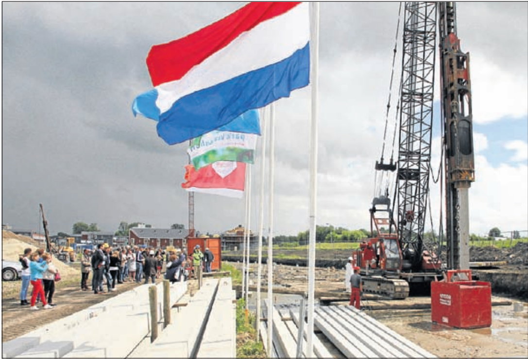
Mijdrechtenaar Martin Troost slaat in Park Krayenhoff een heipaal in de grond voor de nieuwbouw van zeven Liniewoningen
