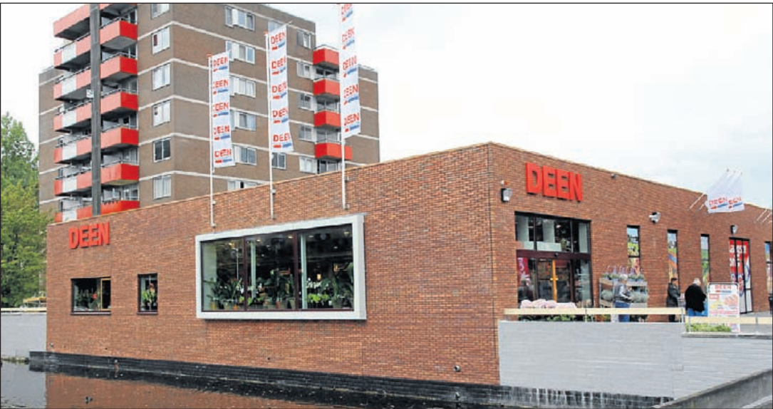
Het voormalige verpauperde winkelcentrum is (bijna) helemaal nieuw opgebouwd
