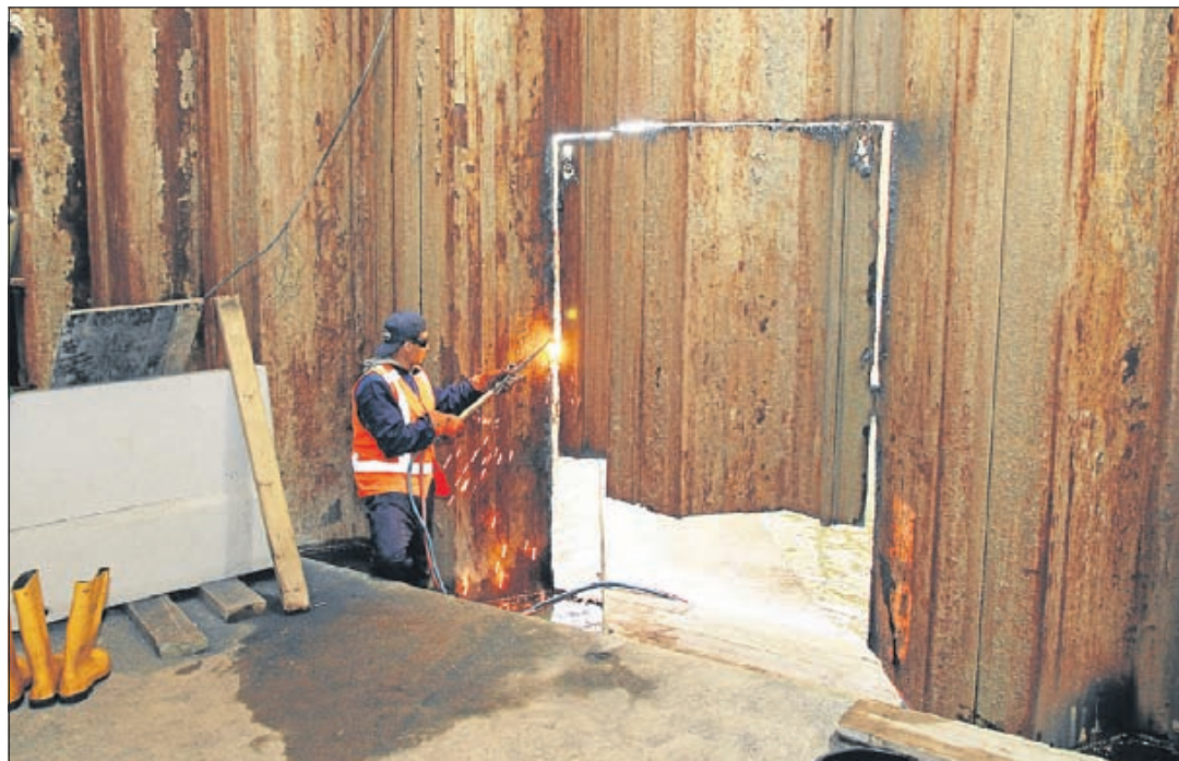
Losbranden van een stuk kopschot dat het oostelijke deel van het westelijke stuk tunnel gescheiden houdt
