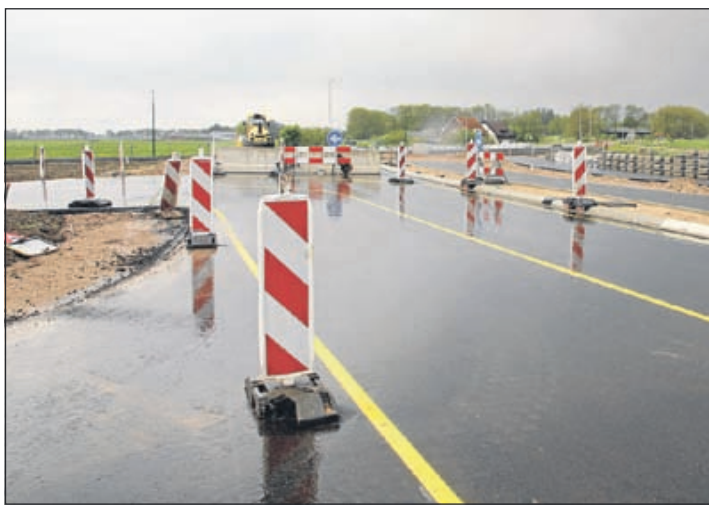
Het nieuwe kruispunt N201/Tienboerenweg krijgt al aardig vorm. Een deel is reeds geasfalteerd en de Tienboerenweg heeft tijdelijk een andere aansluiting op de N201
