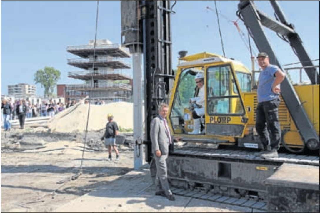
Wethouder Jeroen Verheijen gaat de eerste paal slaan voor woningen van 'De Stelling'. UBA Bouw directeur Louis van Huik (li.) en de heibaas van Plomp Funderingstechnieken geven hem aanwijzingen
