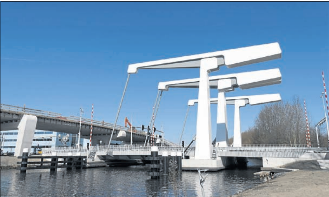
De Bosrandbrug bij Schiphol-Oost met links de fly-over in aanbouw (Foto: Richard van der Brule, RHDHV)
