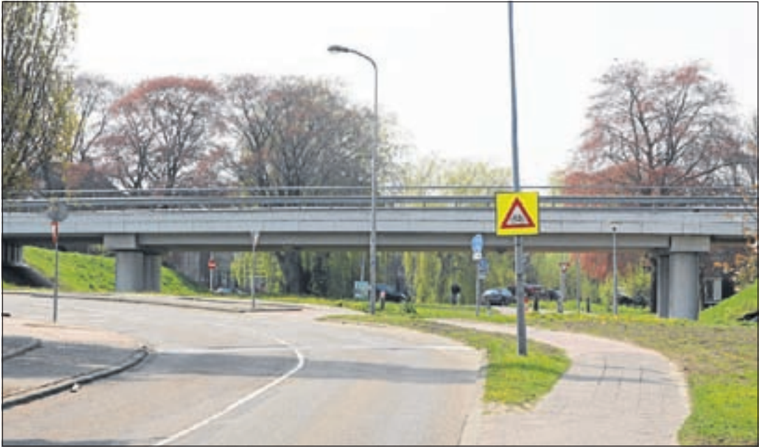
De busbaan wordt bestempeld als calamiteitenweg
