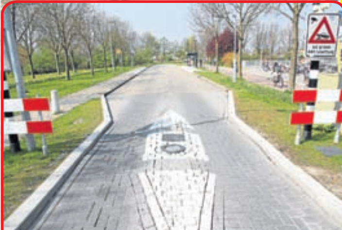
De defecte paal in de busluis wordt vervangen door een werkende. De busluis verdwijnt op den duur
