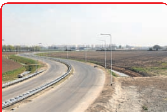
De nieuwe N201, gezien vanaf de fietsbrug op de Noorddammerweg in de richting van de Zijdelweg
