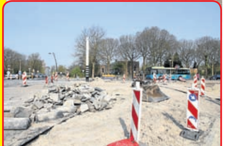
Aansluiting Arthur van Schendellaan op de Zijdelweg afgesloten t/m vrijdag 20 mei
