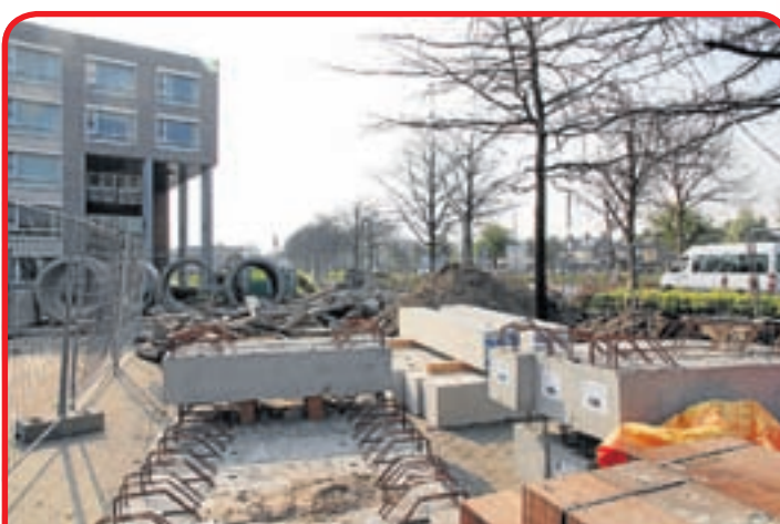
De vervanging van de riolering zal voor de zomer klaar zijn
