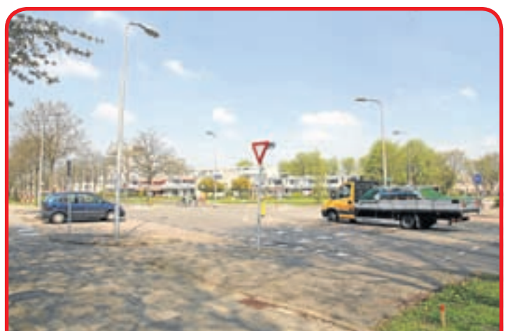
De kruising Wiegerbruinlaan/Achterberglaan wordt een rotonde; 1 juni starten de werkzaamheden
