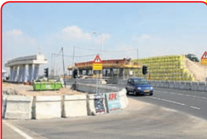
Het viaduct voor de N201 over de Zijdelweg ter hoogte van Carpet Right in aanbouw
