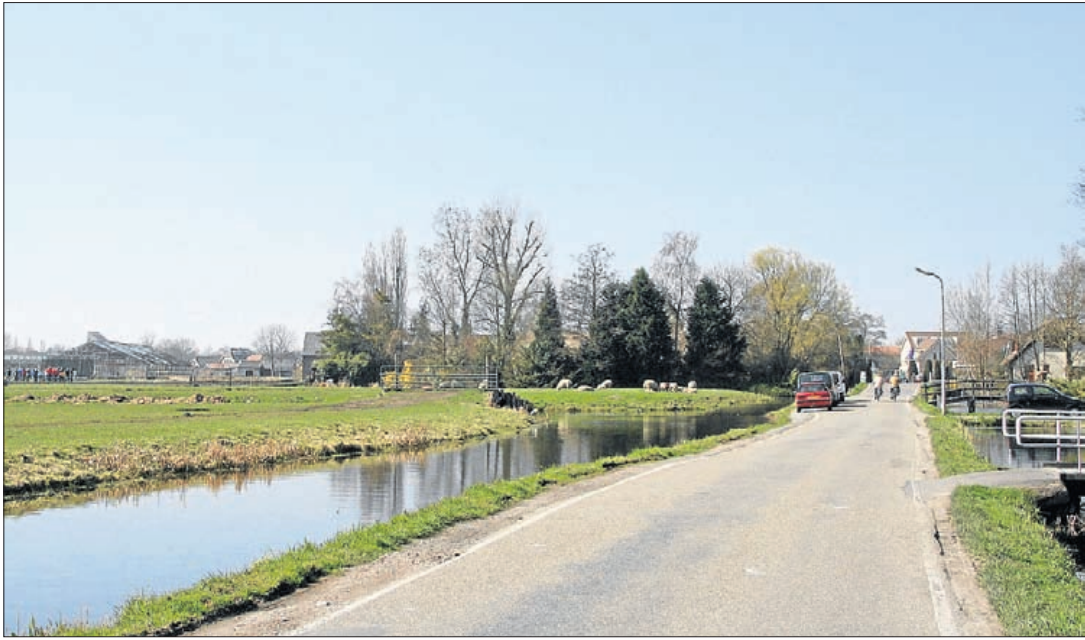
Ook de gevaarlijke oversteekplaats op het Kwakelsepad bij het fietspad naar De Stelling wordt onder handen genomen
