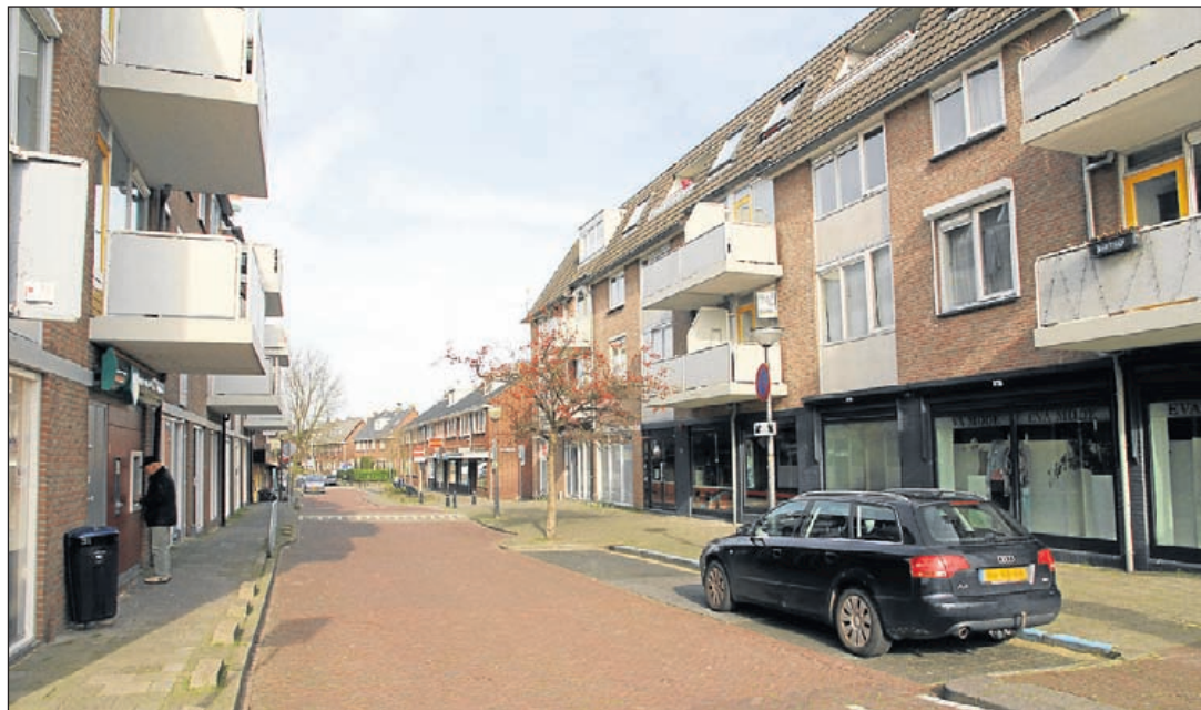
De Koningin Julianalaan wordt het eerst opgebroken voor rioleringswerkzaamheden
