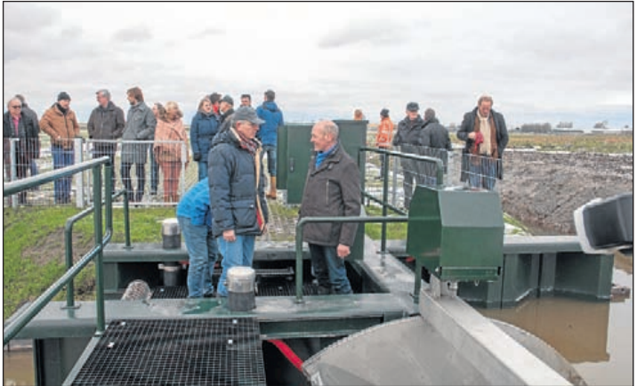
Hier helemaal vooraan de stuw en daar vlak achter het gemaal dat er voor zorgt dat het peil in de waterberging lager blijft en dat de waterberging leeg gepompt als deze onder water heeft gestaan. Van achter het hek bekijken de genodigden het gemaal.
