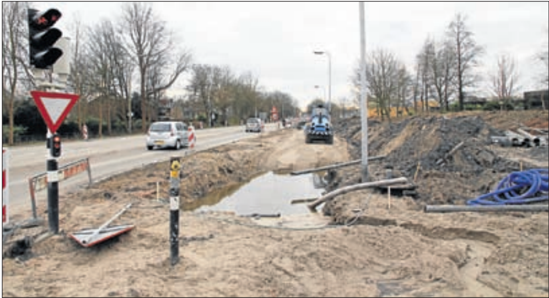
Er wordt volop gewerkt aan de verbreding van het noordelijk deel van de Zijdelweg naar 2 x 2 rijstroken
