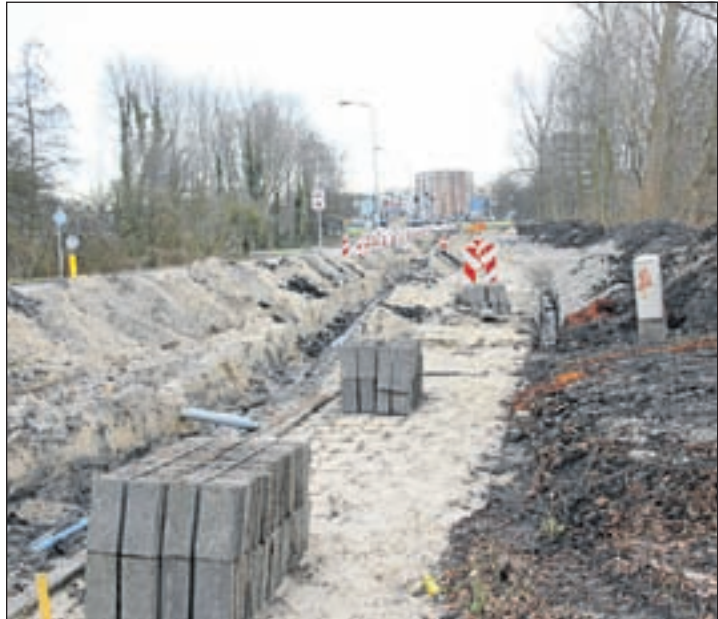
De busbaan in aanleg bij de Watsonweg
