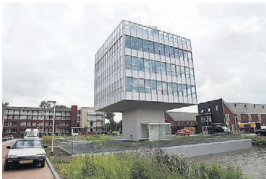
De voormalige IBM toren, een markant punt binnen Park Krayenhoff
