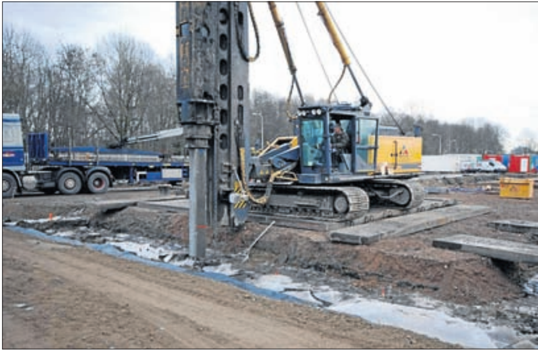
Op 3 januari jl. werd de eerste paal geslagen voor het nieuwe pand van Multimate en Home Decor aan de Wiegerbruinlaan in Uithoorn. Foto: Harry de Groot.
