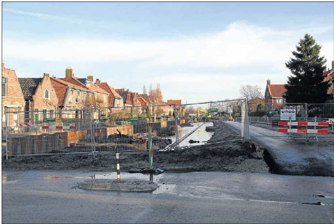
Het Thamerlint is voorlopig nog wel een bouwput
