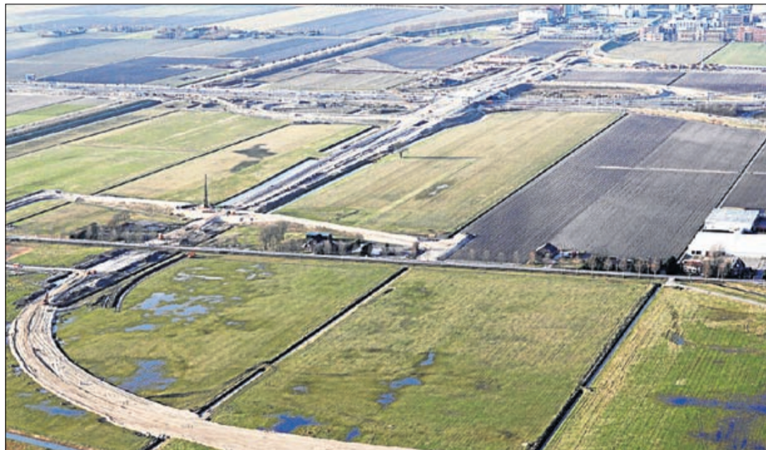
De in aanbouw zijnde aansluitingen van de N201 op rijksweg A4 - bovenkant foto - lopen vertraging op
