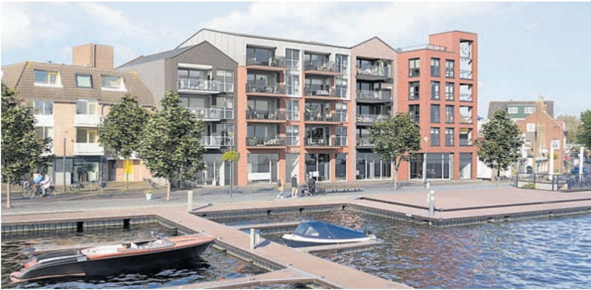
De bouw van project De Rede is inmiddels in volle gang
