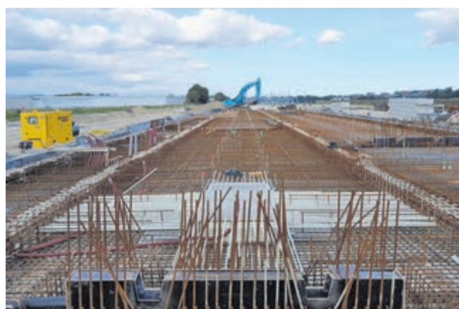
Een deel van de wapening voor de hal is al gereed.
